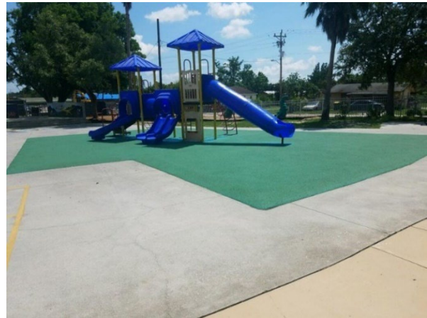
Abbildung 2: Nur 24 Stunden nach dem Einbau erscheint der gleiche Bodenbelag durch die Vergilbung des aromatischen Bindemittels nicht mehr hellblau, sondern grün.
