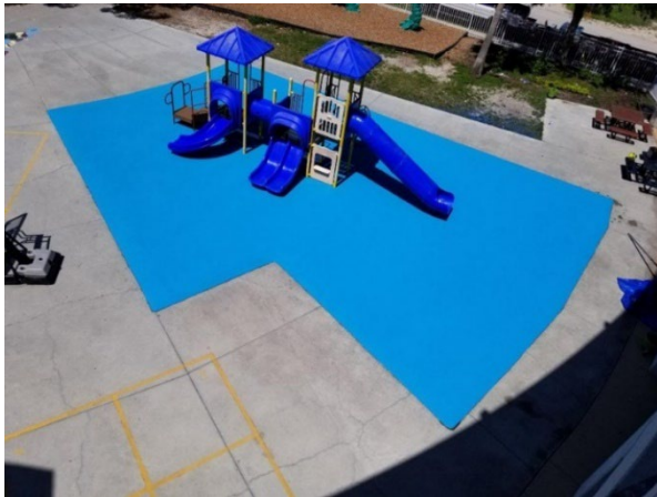
Abbildung 1: Ein mit aromatischem Bindemittel eingebauter Bodenbelag aus hellblauen Gummigranulaten direkt im Anschluss an den Einbau.
